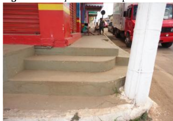
Figura 28. Calçadas das vias públicas
