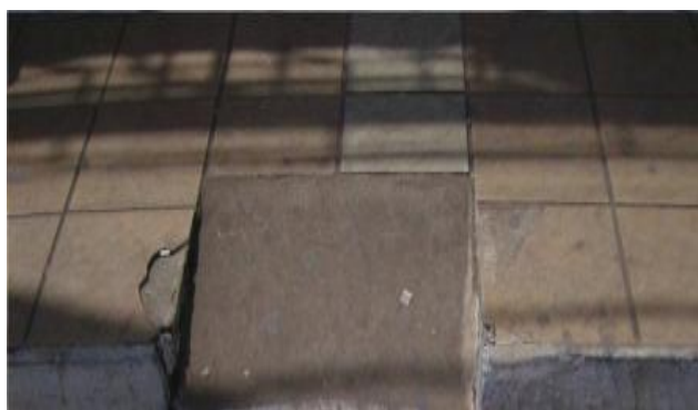
Figura 29. Rampa em calçada de Tucuruí
