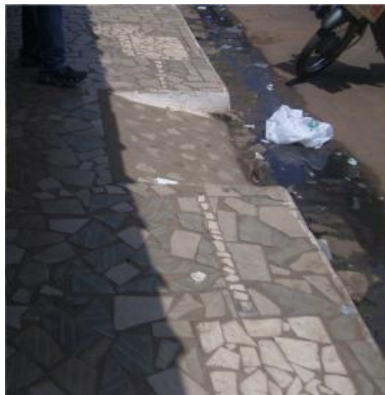
Figura 30. Rampa em calçada de Tucuruí
