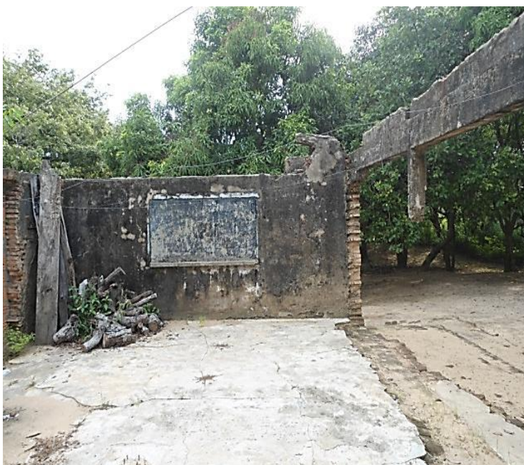
Figura 11: PRÉDIO DA ESCOLA JOSÉ FREIRE DE ALENCAR: hoje ele é utilizado como residência e, a área externa, como estacionamento direcionado aos turistas. Fonte: Cristiano Silva (2013).
